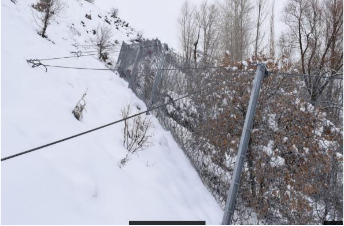
Resim 2.7: Refahiye İlçesi Sarıbayır Köyü Kaya Düşmesi Önlem Çalışmalarından Görünüm (Erzincan AFAD)
