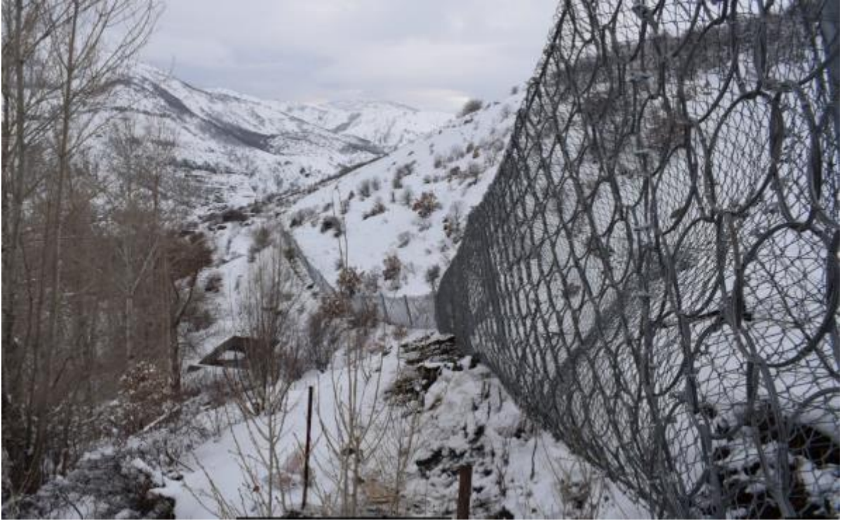
Resim 2.6: Refahiye İlçesi Sarıbayır Köyü Kaya Düşmesi Önlem Çalışmalarından Görünüm (Erzincan AFAD)
