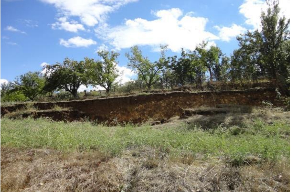
Resim 2.1: Gökseki Köyü'nde Meydana Gelen Heyelandan Görünüm (Erzincan AFAD)
