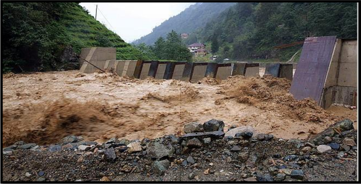
Resim 2.16: Geçirgen Tersip Bendi Örneği (D.S.İ. Genel Müdürlüğü)
