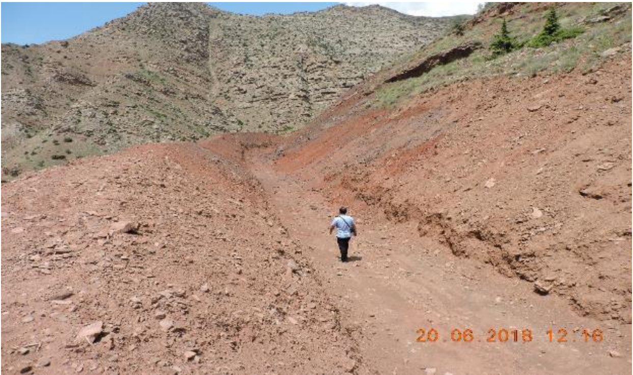
Resim 2.8: Kemah Taşbulak Köyündeki Kanal Açma Yöntemiyle Kaya Düşmesi Önleme Çalışmasından Bir Görünüm. (Erzincan AFAD)
