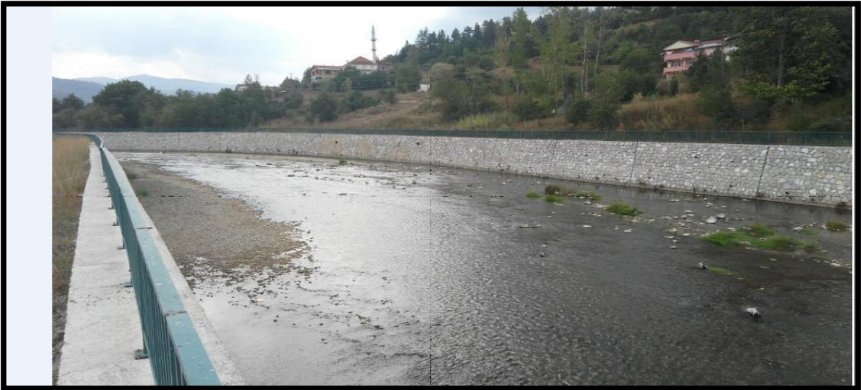
Resim 2.12: Kargir Duvarlı Taşkın Kanalı Örneği (D.S.İ. Genel Müdürlüğü)
